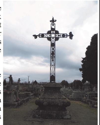
De nos jours, cette croix souffre malheureusement d'importantes altérations : oxydation du fer, multiples desquamations et pertes des surfaces, morceaux cassés ou tordus... L'ensemble est recouvert d'une peinture ancienne très dégradée et faiblement adhérente. Les parties massives sont peu oxydées et les éléments décoratifs en tôle mince sont abîmés voire manquants, mais restent globalement solides.
