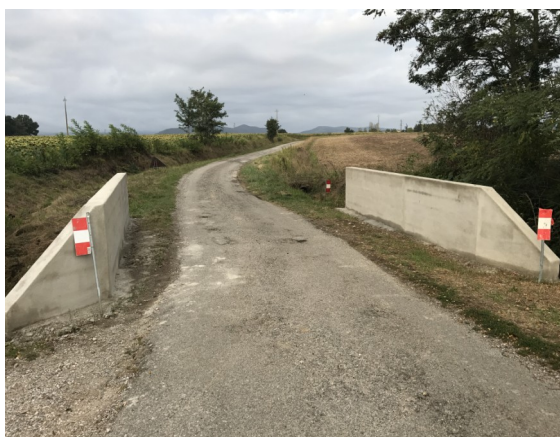
Réfection du parapet du pont de la PRADASSE
