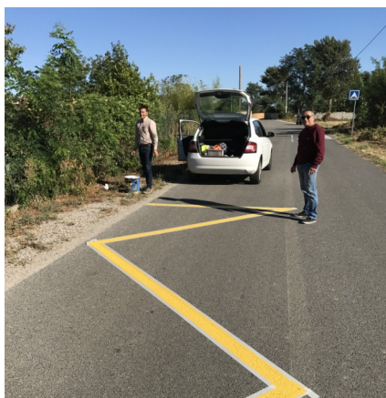
Nouveau point de montée rue du pigeonnier.
